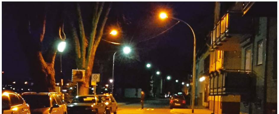
Fußgängerüberweg beleuchtet mit 1.800K (Amber)
