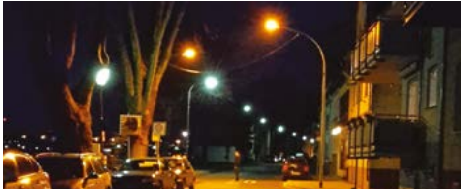
Fußgängerüberweg beleuchtet mit 1.800K (Amber)
